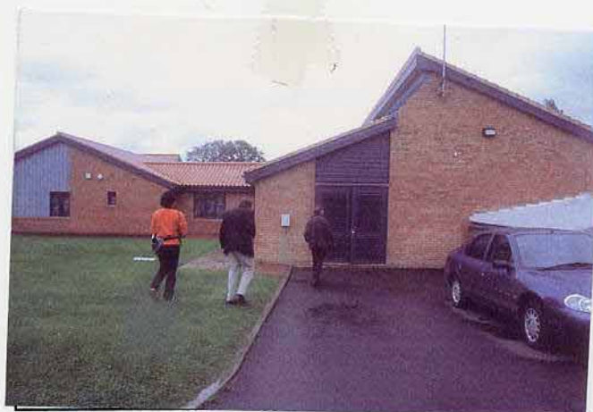
イギリスヘレフォード県 ウエオブリー小学校の暖房事例 正面はボイラー室、左は校舎
