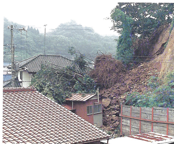
急斜面が崩壊し人家を壊しました
