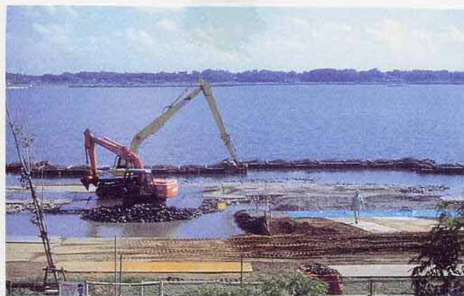
霞ヶ浦の沈床工法
