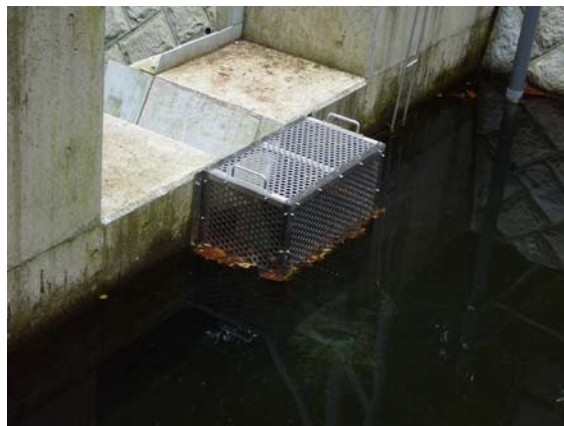
写真3 落ち葉除けカゴ設置状況（左：N03 量水堰 右：N04 量水堰）
