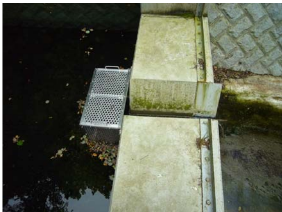
写真3 落ち葉除けカゴ設置状況（左：N03 量水堰 右：N04 量水堰）
