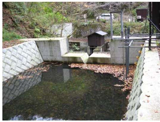
写真1 N03 量水堰の排砂ゲートの改良（左：施工前 右：施工後）
