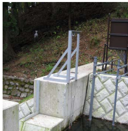
写真2 N04 量水堰の排砂ゲートの改良 （左：施工前 右：施工後）
