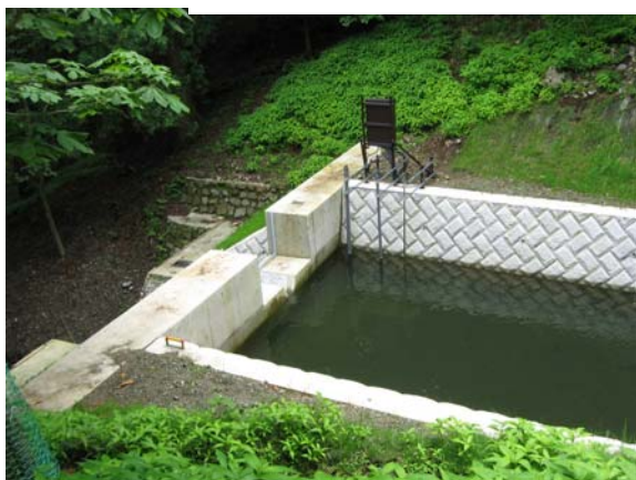
写真1 N03 量水堰の排砂ゲートの改良（左：施工前 右：施工後）
