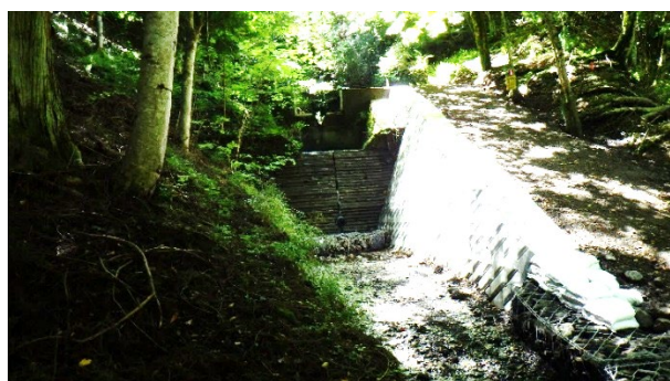
図1 支流N04観測堰(奥地) の管理用進入路の新設
