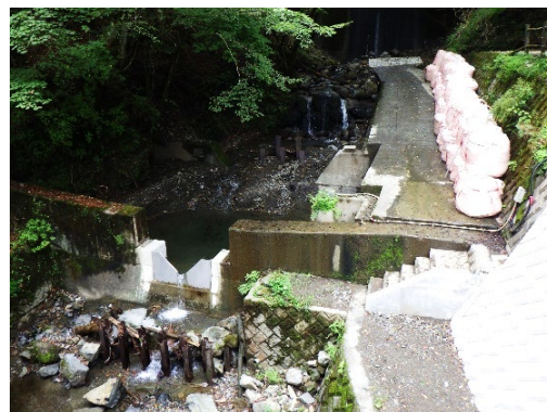
図2 本流観測堰の付け替え、浚渫と 進入路の改修
