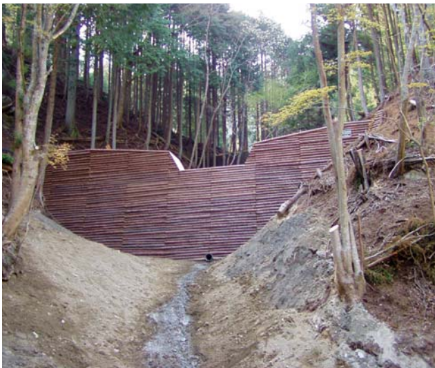
写真5-3 間伐材を型枠に利用した谷止工
