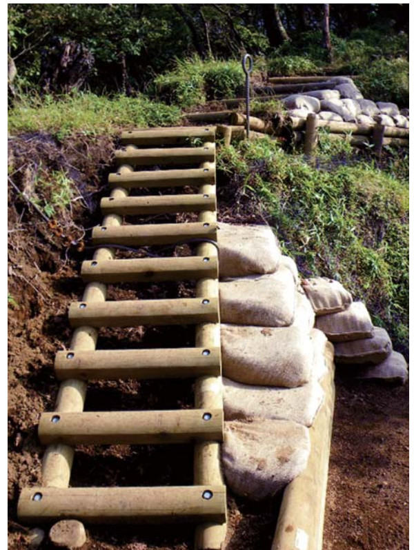
写真5-1 登山道整備で設置された木製の歩道(左上)、ベンチ(右上)、道標(左下)および階段と土留め工(右下)
