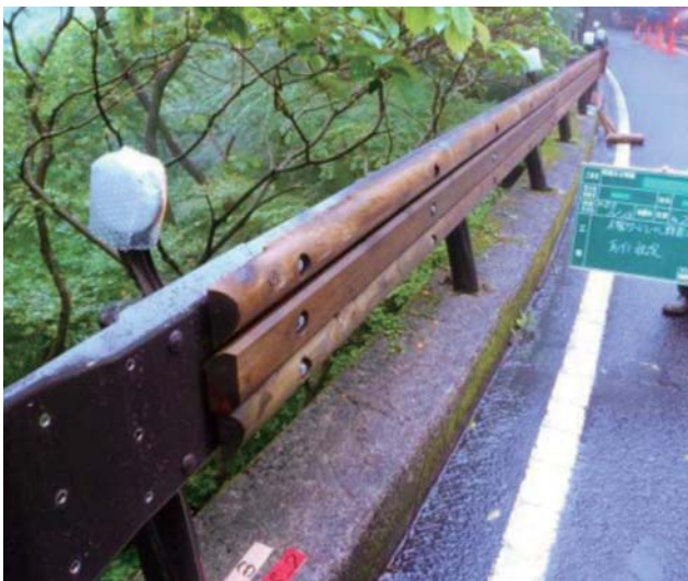
写真5-5 木材で修景したガードレール(左)と景観になじむ木製の視線誘導柵(右)
