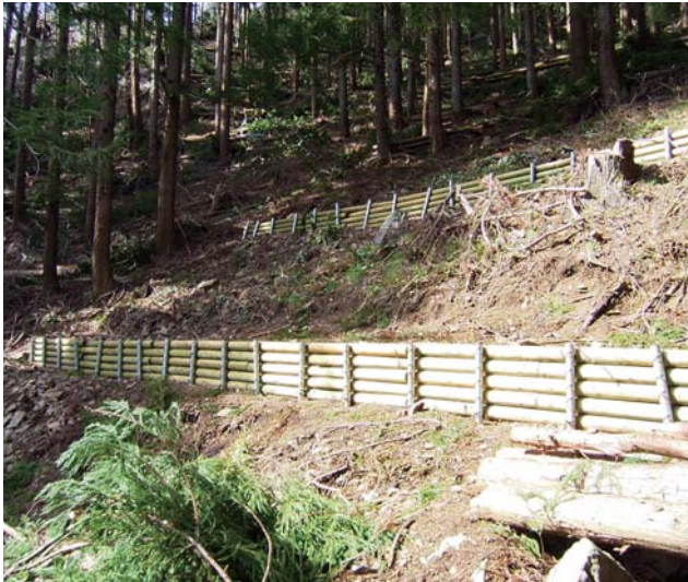
写真5-2 水源林整備で施工された丸太柵工(左)および筋工(右)
