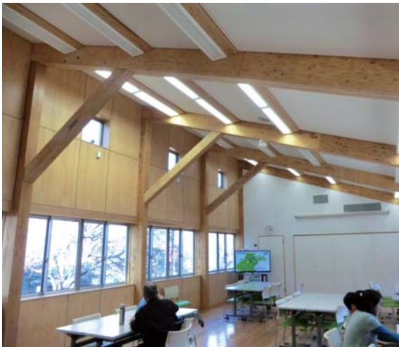
写真5-9 川崎市生田緑地東口ビジターセンターの内装(左)、梁(中)、筋かい(右)
