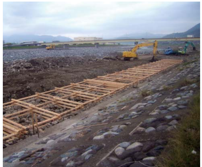
写真5-4 河川工事で施工された木工沈床
