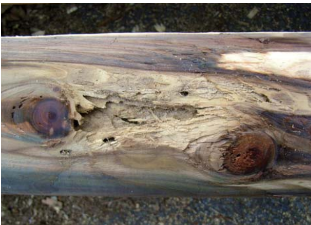
写真1-1 幼虫食害痕の周辺で発生した変色と腐朽(スギ)
