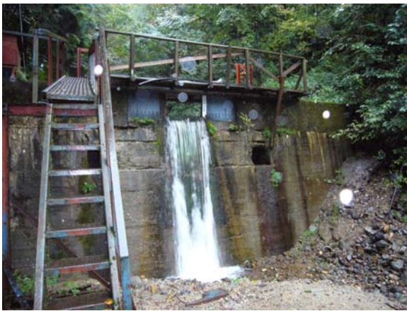
穂高砂防観測所の量水堰（正面）
